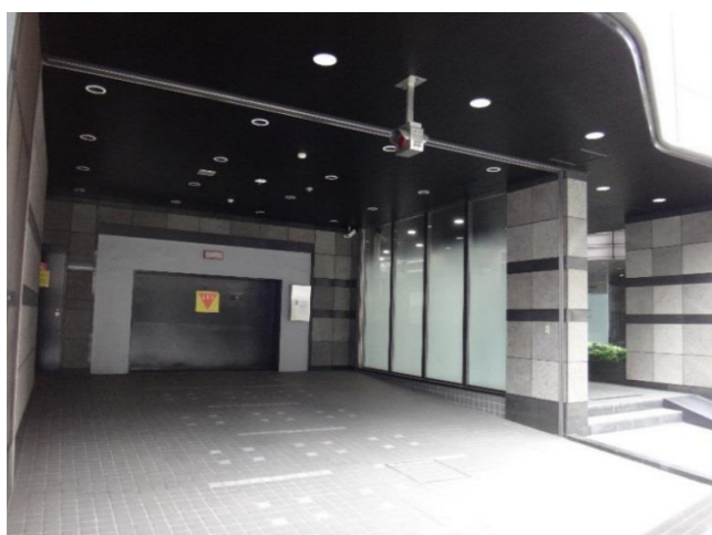
正面道路に面した機械式駐車場
